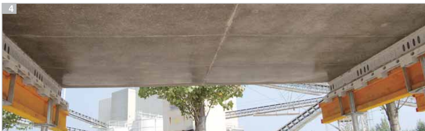
4 Конечный вид до полного высыхания бетонированной поверхности
