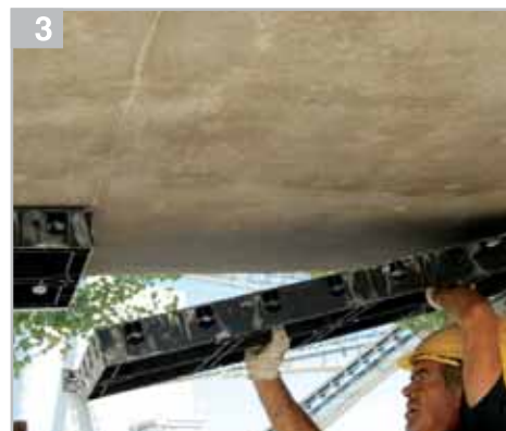
3 Снять панели снизу
