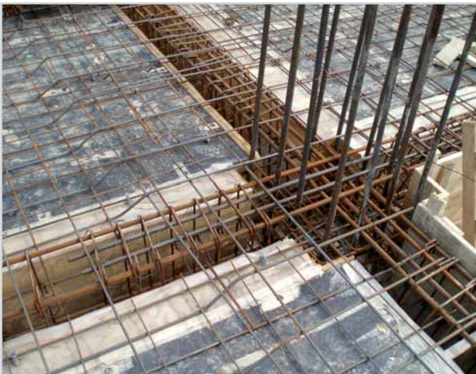
Пример одновременной заливки перекрытия и балок
