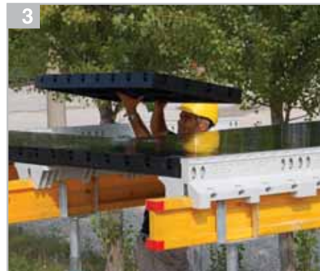
3 Уложить панели GEOPANEL® 120
