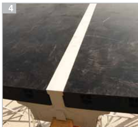
4 Вставка панелей в балку в форме Y
