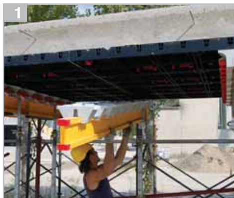
1 Снять балку в форме H
