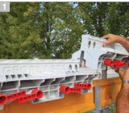
1 Собрать и установить балку в форме Y с клиньями
